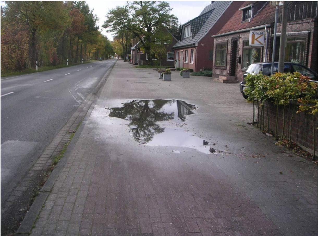
Abb. Sanierungsbedürftig sowie mit gestalterischen Defiziten: Die zentralen Randbereich der K 202
